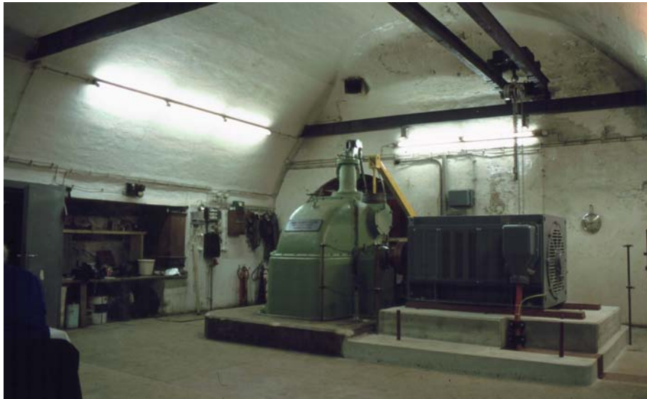
Abbildung 14 Kavernenkraftwerk „Grüner Hirsch“, St. Andreasberg
