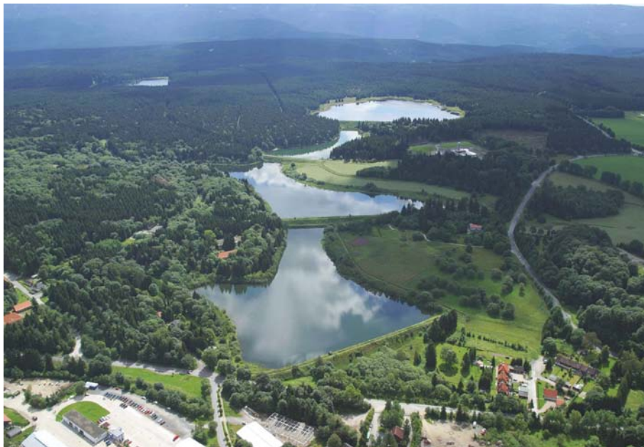
Abbildung 1 Teichkaskade bei Clausthal. Vorn die drei Pfaunteiche (erbaut vor 1661), hinten der Hirschlerteich (1717)
