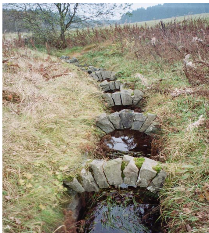
Abbildung 3 Der Zellerfelder Kunstgraben. Die Bögen dienten dazu, den Graben im Winter mit Fichtenzweigen abzudecken, um Zufrieren und einen Stau durch Schnee zu vermeiden.
